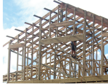
एक भवन निर्माण
