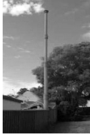
Fig. 16.4: Vent Shaft
